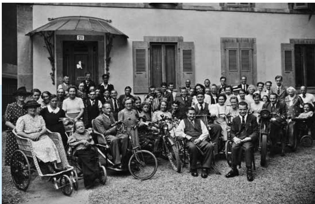
GV Neuenburg 5./6. September 1942, Hôtel de Home AG Neuchâtel 5/6 septembre 1942, Hôtel de Home Photo H. Weibel
